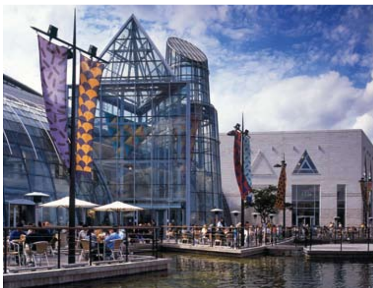
Synco 700 – HVAC-regeling in een multifunctioneel gebouw
